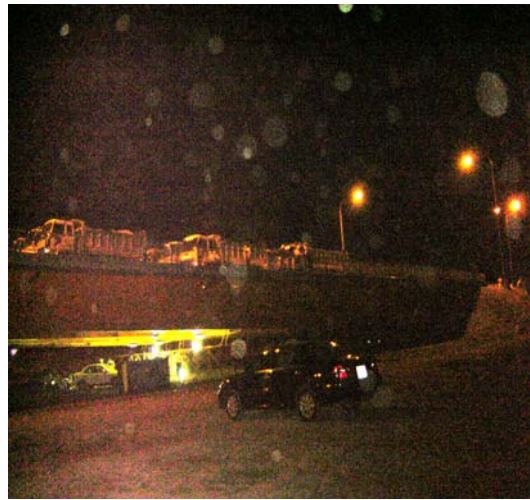
Hình 4. Xếp xe thử tải nhịp cầu dẫn
