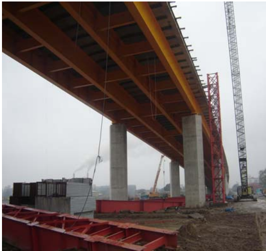
Hình 3. Kết cấu trụ và liên kết gối đặc biệt
