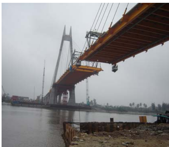
Hình 1. Chuẩn bị hợp long, nối liên chiều dài 17 nhịp cầu Bính
