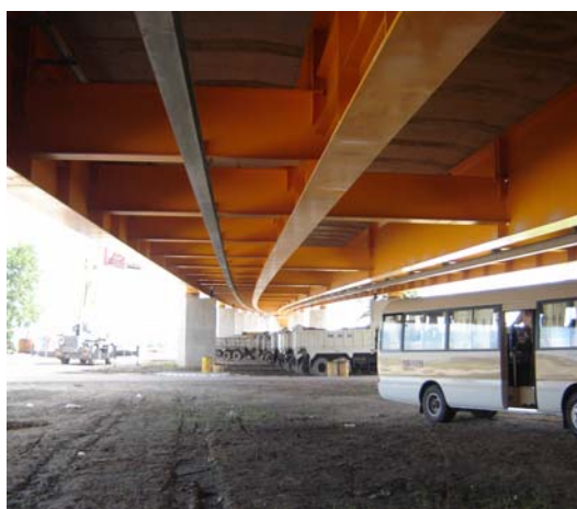
Hình 2. Cầu cong thép nhiều nhịp trong nhịp dẫn của cầu Bính
